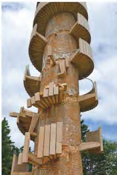
Cette fois-ci, c'est le côté le plus visible de la tour qui s'est effrité. Une quarantaine de blocs sont tombés. PHOTO AIME
