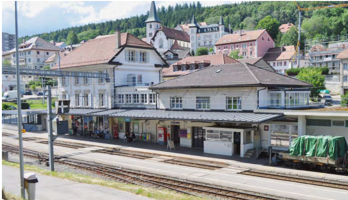
Le réaménagement de la gare de Tramelan dont le crédit se monte à 1 368 263 fr. pour la commune a passé la rampe, hier soir. Les Tramelots auront le dernier mot. MSB
