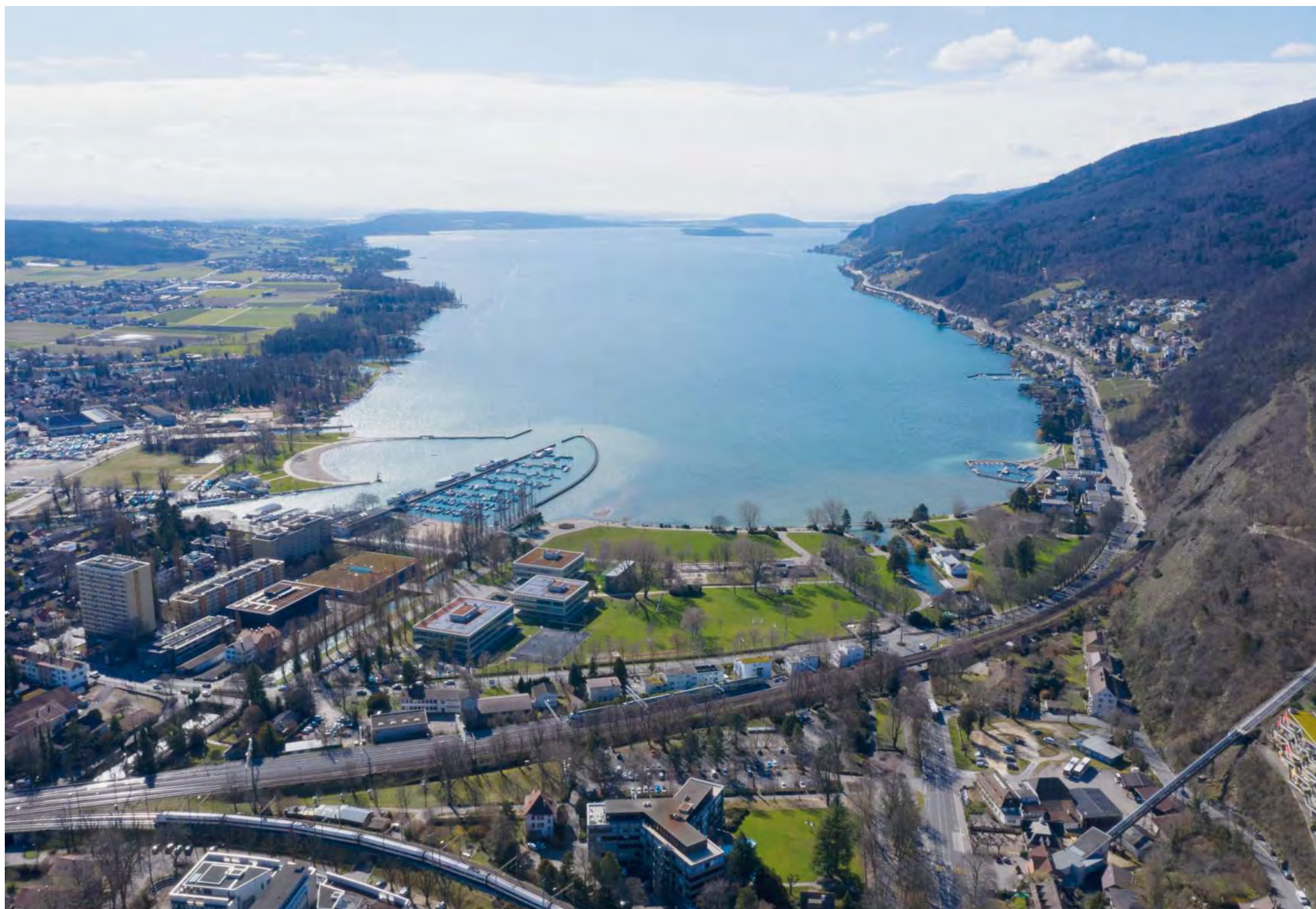
Le lac de Bière est la source principale d'eau potable de la cité seelandaïse. Cette ressource devrait encore durer longtemps malgré le réchauffement climatique. ARCHIVES
