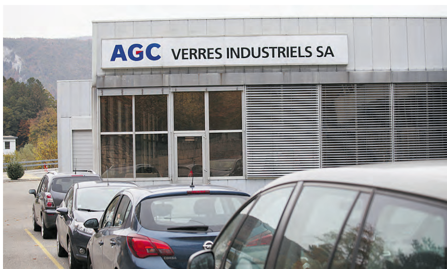
Des effluves s'échappaient des locaux, ce qui avait généré plusieurs appels. ARCHIVES
