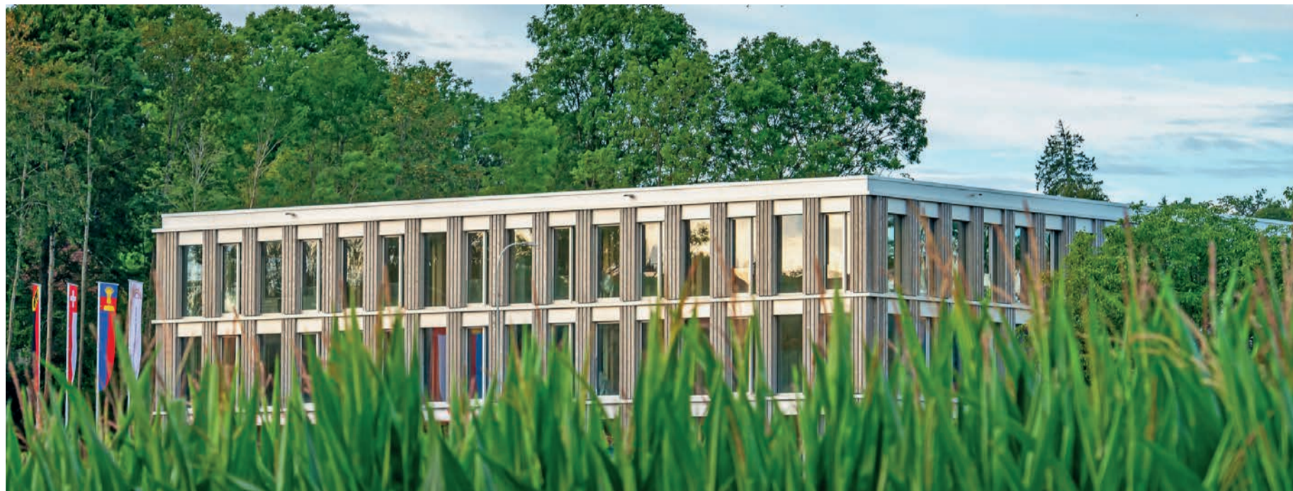
Le nouveau collège des Joncs est construit principalement à l'aide de bois issu des forêts environnantes.
