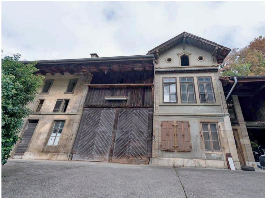
Le bâtiment de près de 150 ans situé au faubourg du Lac 31 aurait dû être démoli.
