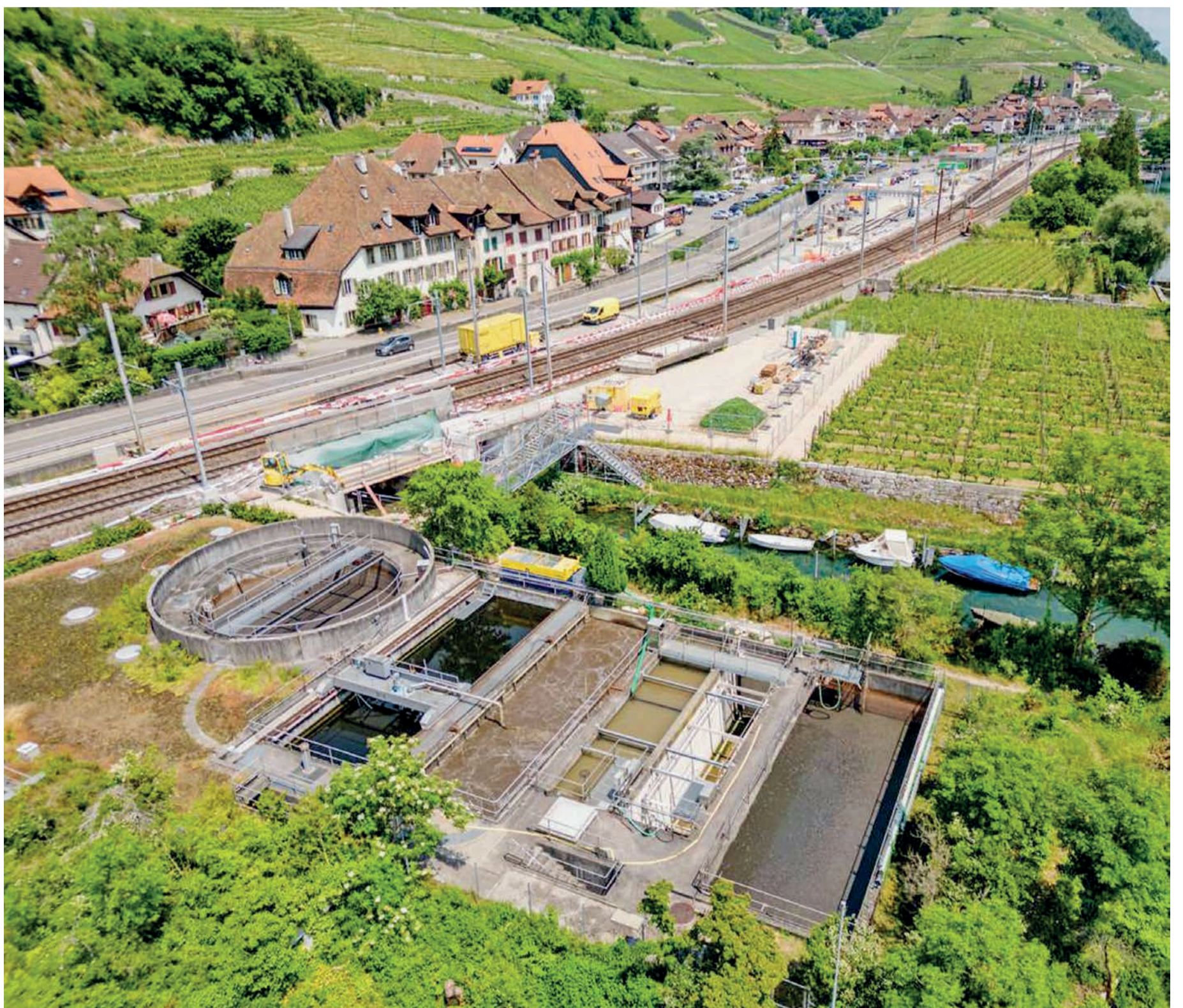
La STEP de la Twannbach ne satisfait plus aux exigences en matière de qualité d'épuration des eaux.
