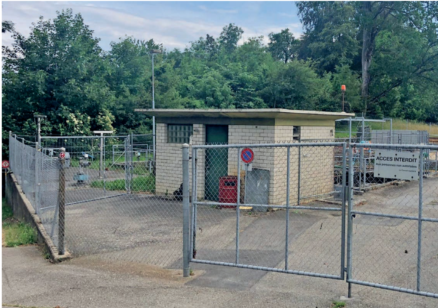
La STEP de Prêles, encore en fonction, sera fermée dès que le raccordement entre Prêles et Cerniaux aura été construit.
