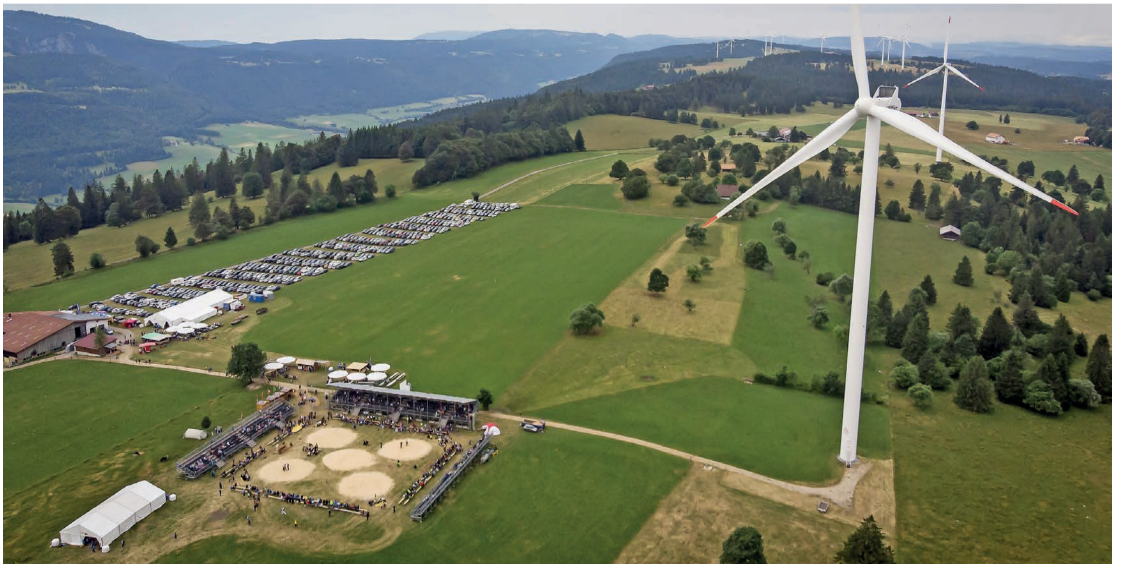
Vue aérienne des éoliennes lors de la fête de lutte du Jura bernois, dimanche 26 juin 2022, au Mont Crosin.
