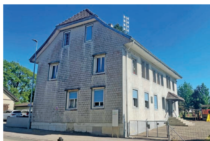
Les travaux d'assainissement de l'école des Gérinnes, aux Reussilles, commenceront cette année encore.
