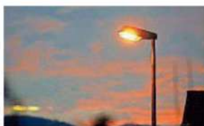
L'éclairage public sur certaines routes cantonales sera fortement réduit durant la nuit.
