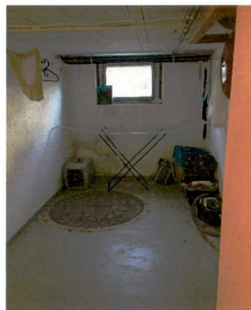
Corridor - escalier accès entrée demi-niveau Rez Inférieur
