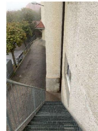
escalier de secours
