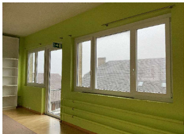
accès escalier de secours
